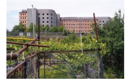
Raccordo autostradale Torino-Caselle Edificio uffici in abbandono
