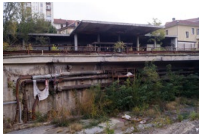
Lucento Parco via Calabria, binari ex Teksid
