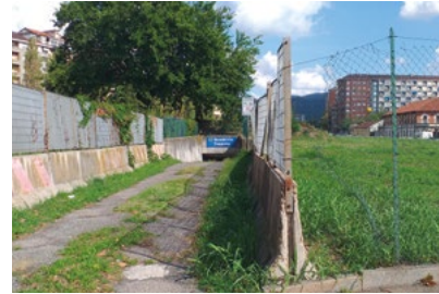
largo Orbassano Accesso alla stazione Zappata (mai inaugurata)
